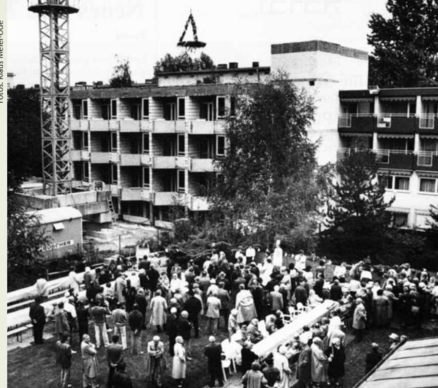
Das Richtfest für das Jüdische Altenzentrum in der Bornheimer Landwehr am 18. November 1973
